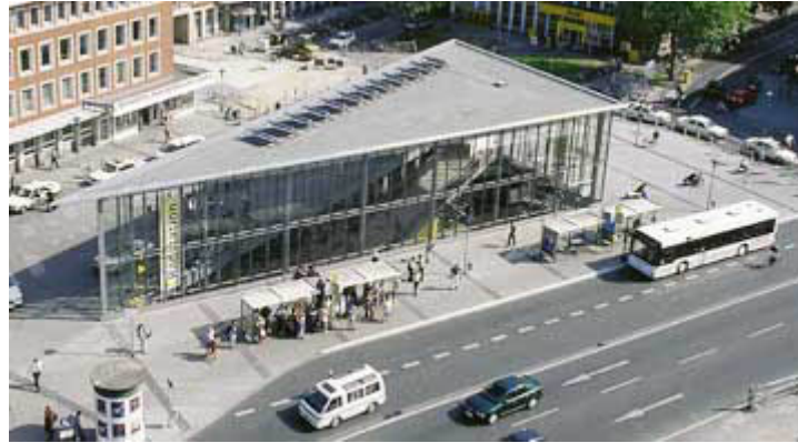
Bild 1. Den ljusa öppna entrén till cykelgaraget med plats för 3 000 cyklar under markplan utanför centralstationen i Münster. Ett intressant föredöme (se vidare bilaga 1).
