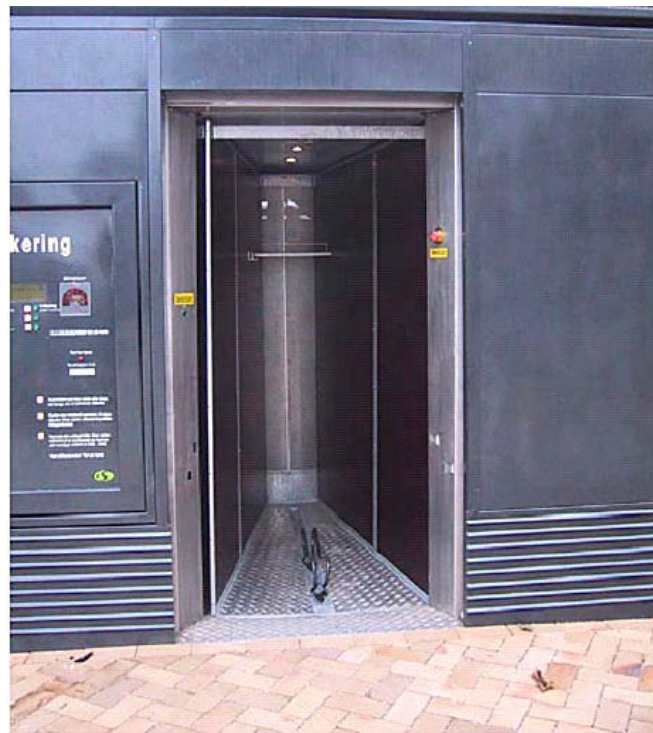
Bild 2:16. Parkeringshusets öppning. Den 21a tårtbiten är alltid tom och vänd mot öppningen. Elektronisk övervakning ser till att ingen befinner sig i förvaringsutrymmet när karusellen snurrar till förvaringsläge. Odense.
