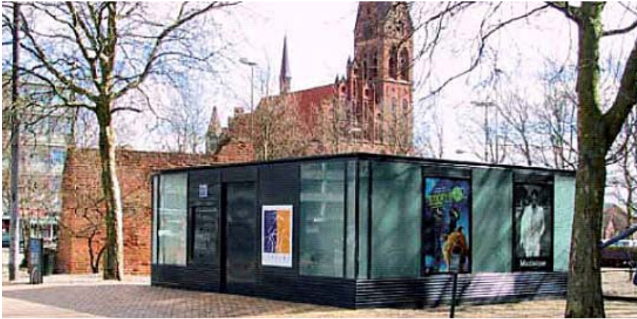
Bild 2:15. Automatiskt parkeringshus i Odense. Huset är 6 x 6 meter och rymmer en karusell med 21 tårtbitar för 20 cyklar. Se vidare följande bilder.
